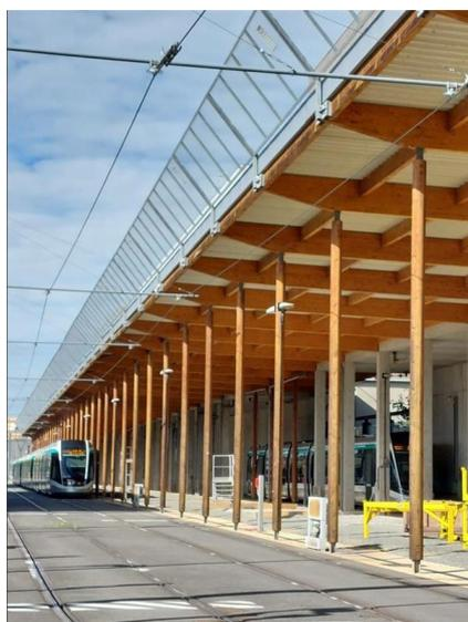
Une « casquette » a pour objectif de protéger les logements en cas d'incendie au niveau du tramway, de limiter l'impact des flammes et des fumées, mais possède également comme vertu de limiter les nuisances sonores.
