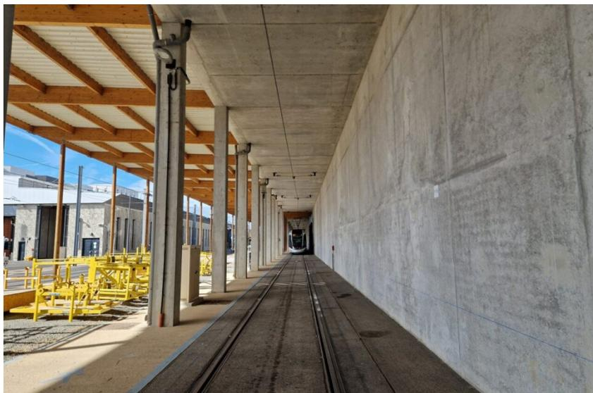
L'équerre, la partie en béton à droite de la photo, est dissociée de l'immeuble pour empêcher l'effet vibratoire inhérent à la présence de tram, de se propager dans les appartements.
